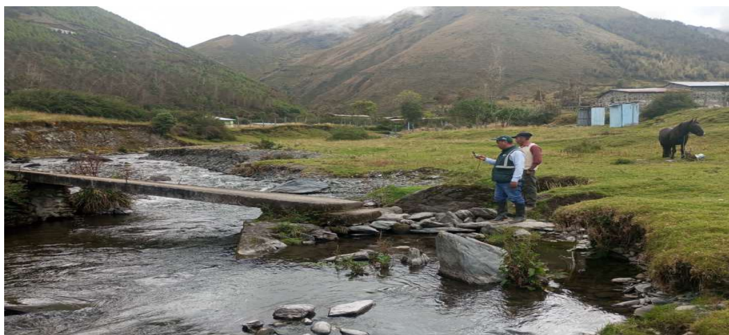
IMAGEN 03: VISTA DE AFECTACIÓN DE BASE DEL PUENTE PEATONAL POR EFECTOS DE EROSIÓN Y SOCAVACIÓN EN LA MARGEN IZQUIERDA DE LA QUEBRADA RANGRACANCA (RIO CHORRILLOS), EL PUENTE(RUSTICO) SIRVE PARA LA CONECTIVIDAD DE
